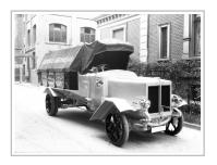
Büssing Typ II (1914): Erster Lkw mit Kardan, elektrischen Frontscheinwerfern und Gas-Positionslampen.
